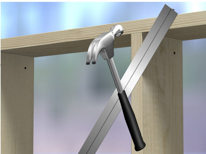
Fig. 31 Avstivningsstag bankes inn i slissen
