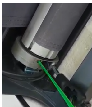
Bilde 2. Markisen er rullet omtrent en runde tilbake slik at duken blir stram.
