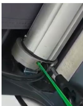
Bilde 1. Markisen er rullet helt ut slik at sylindren viser, da kan det bli svai i duken.
